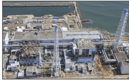
ภาพหลังการระเบิด โรงไฟฟ้านิวเคลียร์ ฟูกูชิมะ
