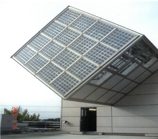
รูปที่ 4.7 ชุดแผงเซลล์แสงอาทิตย์ที่ติดตั้งเป็นส่วนหนึ่งของอาคาร
