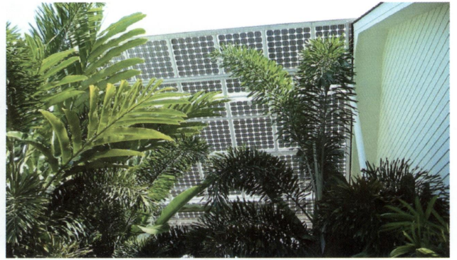
รูปที่ 4.6 ชุดแผงเซลล์แสงอาทิตย์ที่ติดตั้งบนโครงบังแดด
