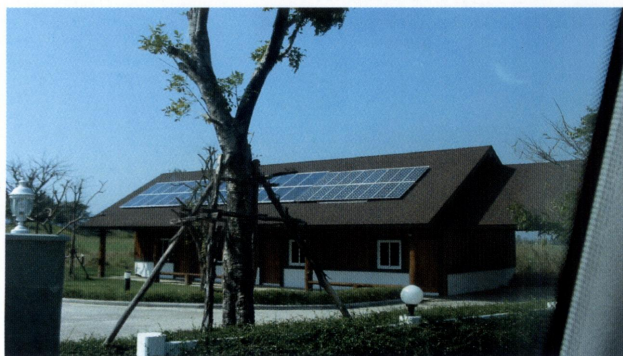
รูปที่ 4.5 ชุดแผงเซลล์แสงอาทิตย์ที่ติดตั้งบนหลังคา
