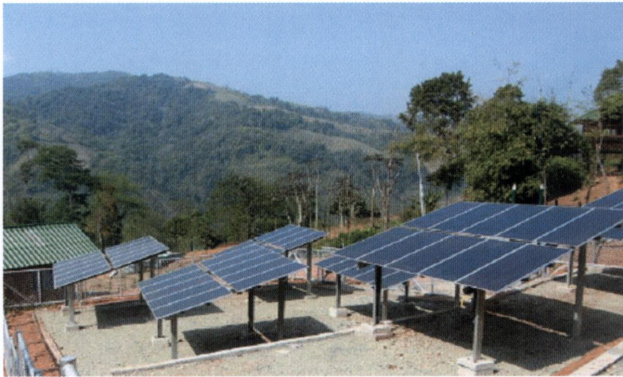
รูปที่ 4.4 ชุดแผงเซลล์แสงอาทิตย์ที่ติดตั้งบนพื้นดิน
