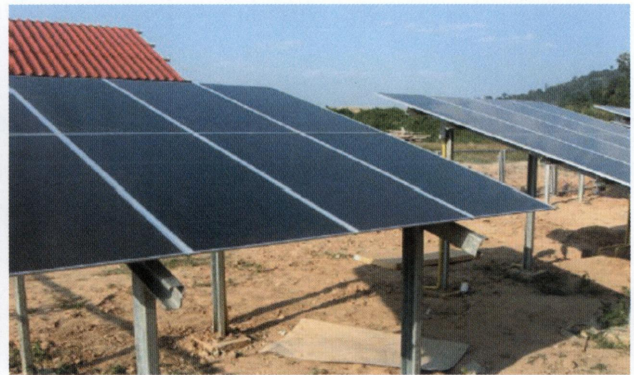
รูปที่ 4.4 ชุดแผงเซลล์แสงอาทิตย์ที่ติดตั้งบนพื้นดิน
