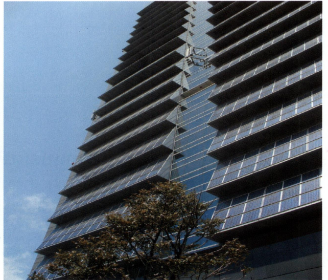
รูปที่ 4.7 ชุดแผงเซลล์แสงอาทิตย์ที่ติดตั้งเป็นส่วนหนึ่งของอาคาร
