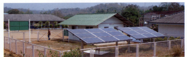
รูปที่ 3.4 ระบบผลิตไฟฟ้าด้วยเซลล์แสงอาทิตย์สำหรับโรงเรียนชนบทที่ไม่มีไฟฟ้า จังหวัดกาญจนบุรี
