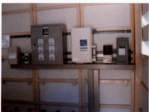
รูปที่ 3.7 อุปกรณ์ต่างๆ ของระบบผลิตไฟฟ้าด้วยเซลล์แสงอาทิตย์ สำหรับศูนย์การเรียนรู้ชุมชนบ้านห้วยไทร จังหวัดแม่ฮ่องสอน
