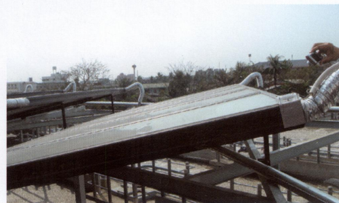
รูปที่ 3.27 ระบบผลิตน้ำร้อนพลังงานแสงอาทิตย์ บริษัทไทยรวมสินพัฒนาอุตสาหกรรม จำกัด
