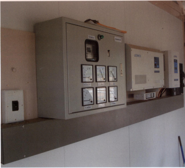
รูปที่ 3.5 การติดตั้งอุปกรณ์ควบคุม ภายในอาคารควบคุม
