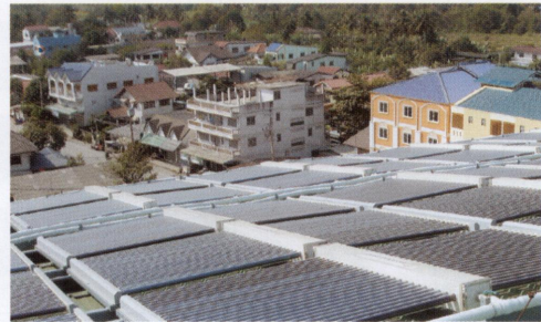
รูปที่ 3.25 ระบบผลิตน้ำร้อนพลังงานแสงอาทิตย์ โรงเรียนนานาชาติไทย-จีน จ.สมุทรปราการ
