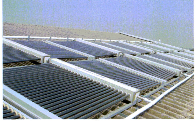
รูปที่ 5.10 ระบบผลิตน้ำร้อนพลังงานแสงอาทิตย์ โรงพยาบาลพุทธชินราช จ.พิษณุโลก
