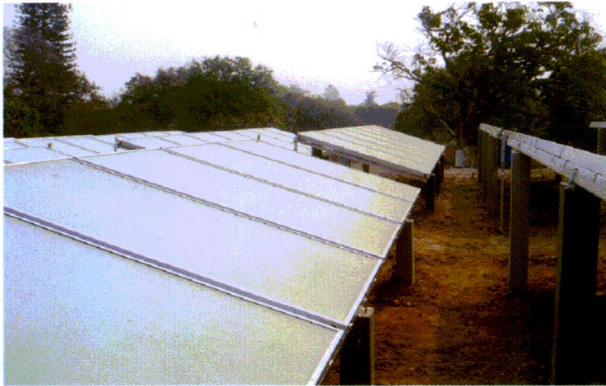
รูปที่ 5.13 ระบบผลิตน้ำร้อนพลังงานแสงอาทิตย์ หจก.ภูมิไพร (ศูนย์ผลิตภัณฑ์สมุนไพรอภัยภูเบศร)
