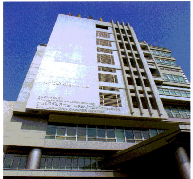
รูปที่ 5.5 อาคารศูนย์วิจัยศึกษาและบำบัดโรคมะเร็ง สถานที่ตั้งระบบทำน้ำร้อนพลังงานแสงอาทิตย์ ชั้นดาดฟ้าอาคาร
