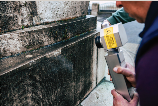
การทำความสะอาดพื้นผิววัตถุโบราณด้วยเลเซอร์
